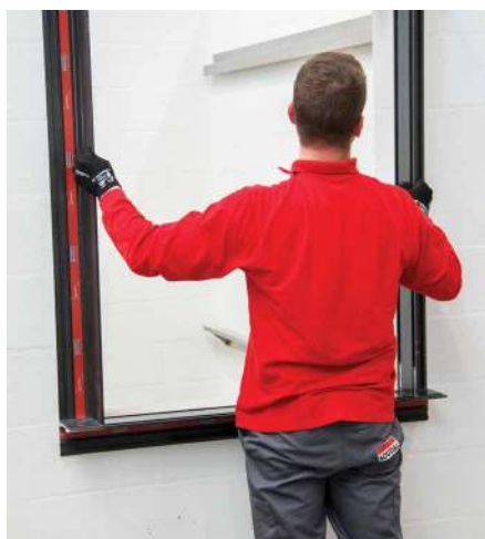
09 Tõstke raam üles ja suruge see vastu seina, liigutades üles-all ja vasakule-paremale
