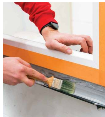
17 Tihendage aken väljaspoolt pastaga Soudatight Hybrid
