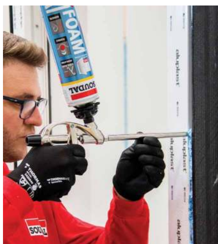
15 Eemaldage vedrulöksud ja täitke kinnitusraami ja aknaraami vaheline vuuk
