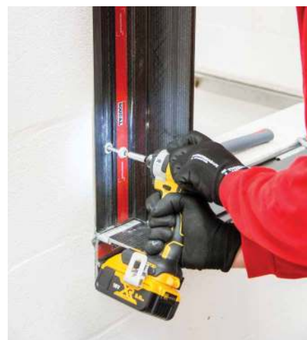
11 Kinnitage raam seinale nõuetekohaste kruvide ja tüüblitega
