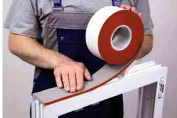
Soudaband Aktiv Plus paigaldamine aknaraamile
