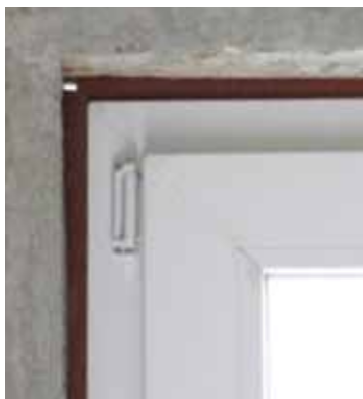
Näide riba paigaldamise kohta akna nurga kohal
